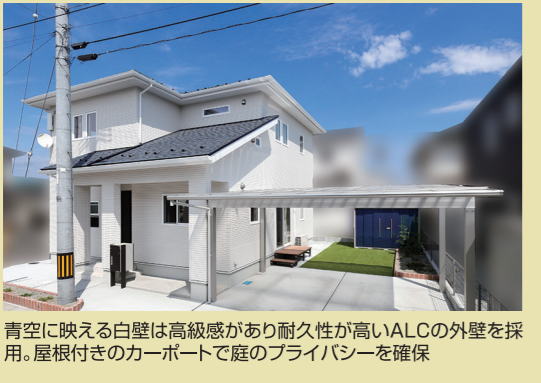
青空に映える白壁は高級感があり耐久性が高いALCの外壁を採用。屋根付きのカーポートで庭のプライバシーを確保
