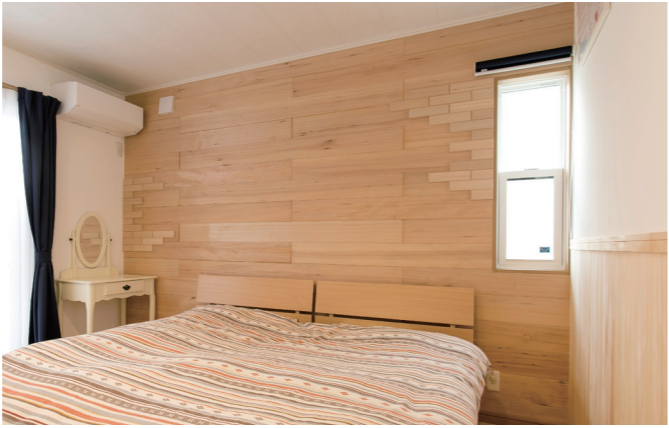
頭に近い壁の一面にモミの木を貼った主寝室。「夜はぐっすり眠れて、朝はすっきり起きられるようになりました」とご主人。天井はホルムアルデヒドを吸収するソフトーンを採用
