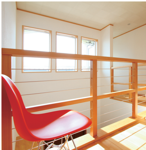
明るく日差しが差し込む2階ホール。木のフレームに細いアルミパイプを配した手すりのアイデアとデザインはYさんのオリジナル。
