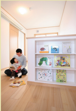
2階の階段を上がった通路部分。壁をくりぬき、収納スペースを確保、ちょっとした工夫が楽しい。
