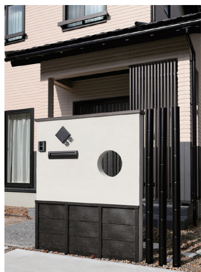
目隠しにもなる縦格子と合わせて焼き杉の黒い板塀をイメージした門壁は、和モダンな外観と調和して室内への期待を誘う
