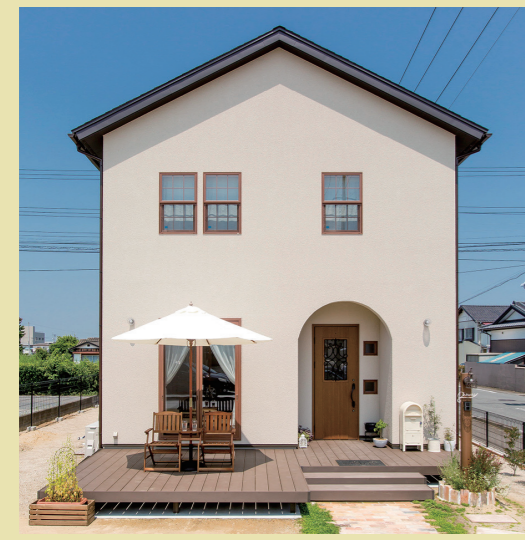
外壁は塗り壁の質感を希望。上げ下げ格子窓や木製風サッシ、アーチ型のポーチが優しいプロヴァンス風の佇まい
