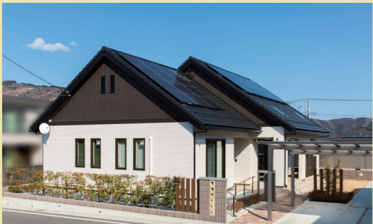
外構や植栽と調和する矩刈配の屋根が印象的な外観。将来を見据えて玄関アプローチに手すりとしロープを設けた
