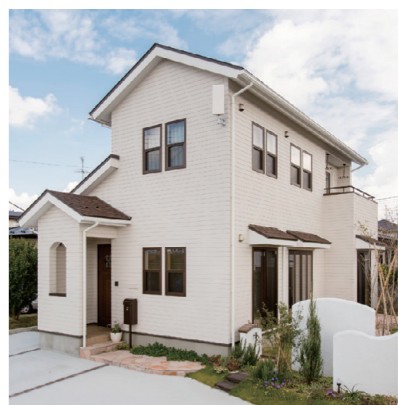
屋根付きの玄関ポーチに上げ下げ窓、曲線を探り入れた可愛い外観は、ヘンゼルとグレーテルのお菓子の家をイメージしたそう
