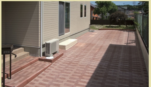
庭の駐車スペースには、ブロックを噛み合わせるように敷きつめるレンガ風のインターロッキングを配しました。奥には家庭菜園やバーベキューができる庭を作る予定です。
