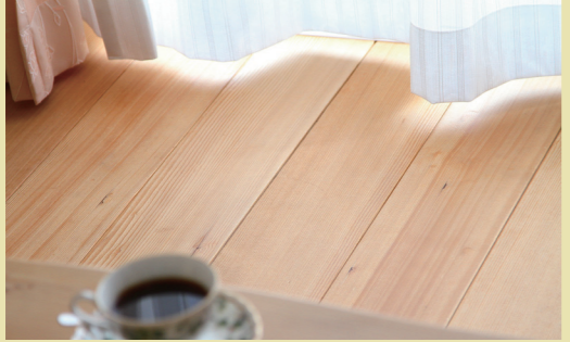
もみの木の床は「掃除がしやすく、助かります」と奥さま。調湿作用で毎年悩まされた結露もなく快適です。
